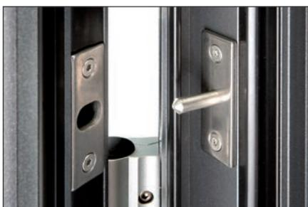
**2 Aushebesicherungen** im oberen und unteren Bereich
